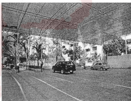
บริเวณลานจอดรถ
