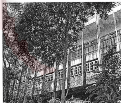
ภาพอาคาร 60 ปี เฉลิมพระเกียรติ ใช้เป็นอาคารจัดแสดง (ถ่ายจากตรง)
