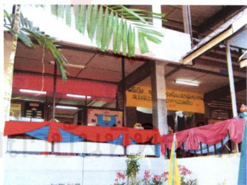
ที่ทำการธนาคาร โรงเรียน อาคาร ๑ โรงเรียนสองพิทยาคม
